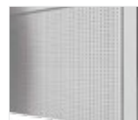
Introduction d'air neuf à basse vitesse au travers du panneau perforé
