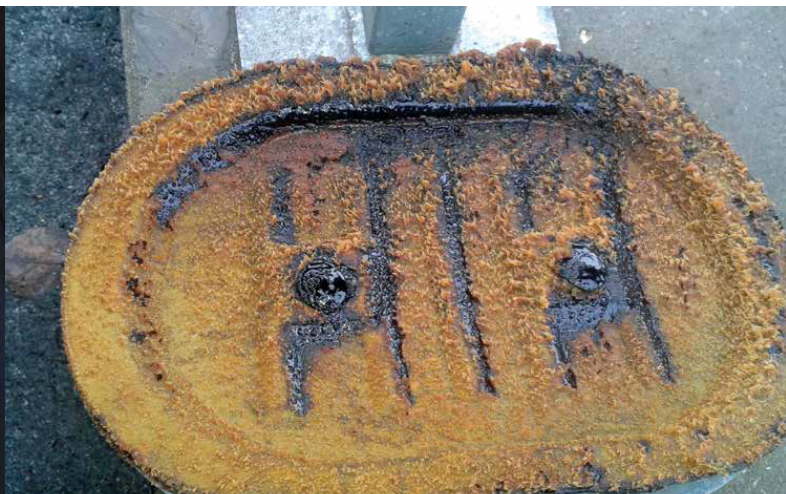
Trappe d'inspection sans technologie OUR - Non nettoyée depuis 12 mois
