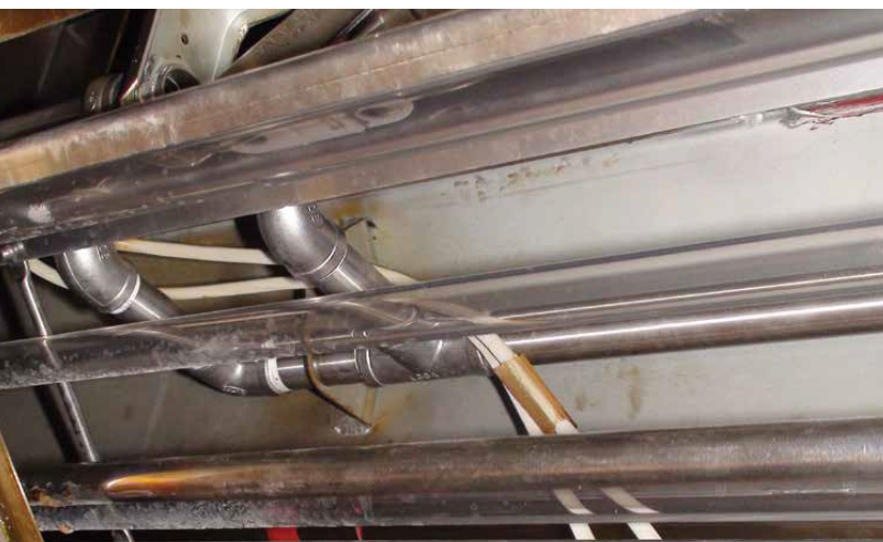
HOTTE ÉQUIPÉE DE LA TECHNOLOGIE UV-C – N'A PAS ÉTÉ NETTOYÉE DEPUIS 6 MOIS
