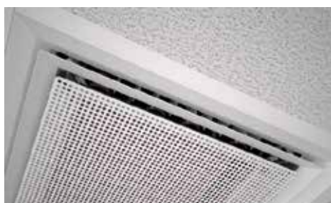
Sous-face standard Perforations circulaires disposées en carré
